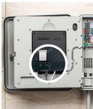
a2c-WLAN WLAN-Modul für ACC2- Steuergeräte, Verwaltung in Centralus-Software Seite 127
