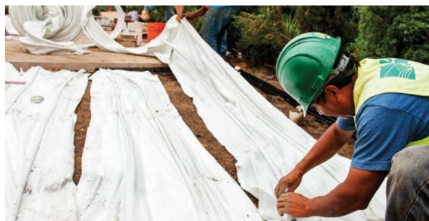
Пример Установки Eco-Mat
